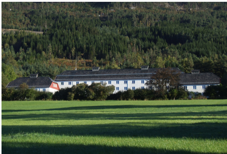
Søsterhjemmet sett fra sør. Foto: Leif Anker, Forsvarsbygg.
