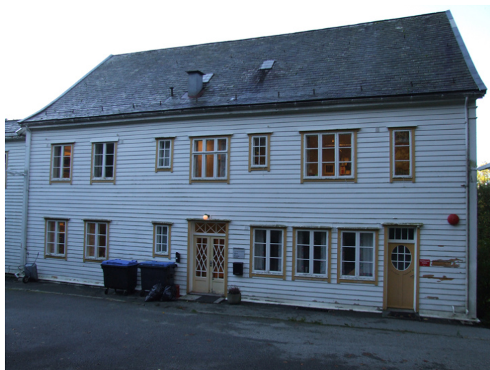
Bak-/nordsiden av bygningen. Foto: Leif Anker, Forsvarsbygg.
