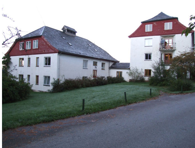
Bygningen sett fra øst. Foto: Leif Anker, Forsvarsbygg.
