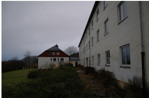
Hovedfasade mot vest med nordre sidefløy. Foto: Marte Oftedal, Forsvarsbygg.
