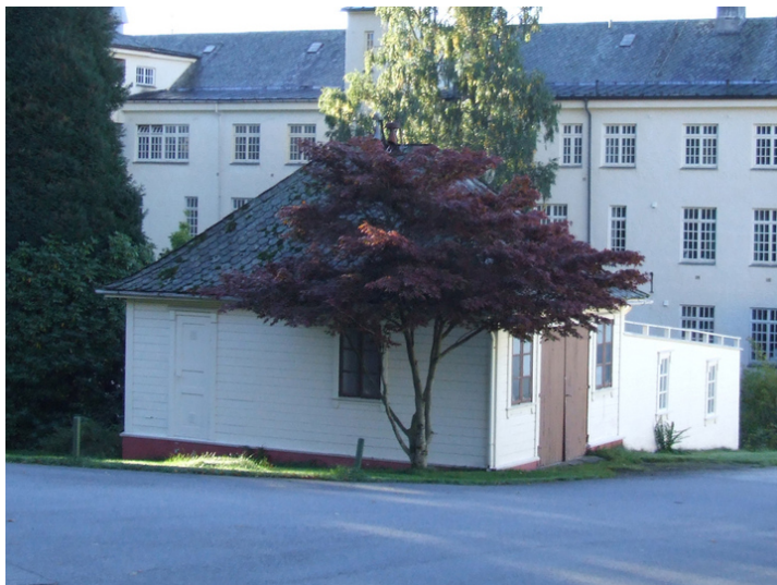
Brannstasjonen sett fra nordvest. Foto: Leif Anker, Forsvarsbygg.
