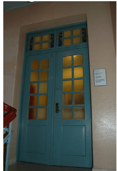
Dør mot trapperom. Foto: Marte Oftedal, Forsvarsbygg.
