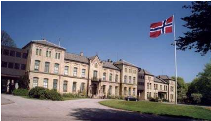
Administrasjonsbygget ved Sørlandet sykehus, Kristiansand.
