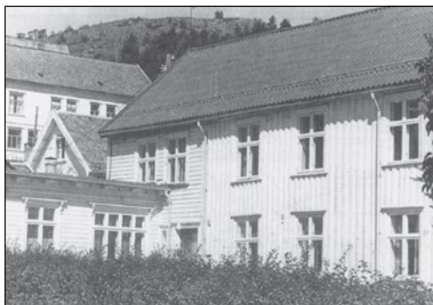
Radesjukehuset i Flekkefjord blei etablert i 1776, men bygningen på bildet var frå 1810. Trass i protestar blei det rive i 1992. Bilde: Avisen Agder.
