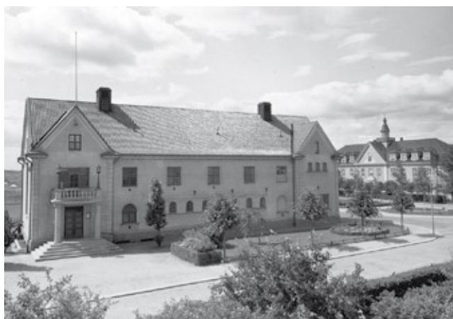
Sarpsborg bad var eit typisk uttrykk for tidas syn om at befolkninga skulle ha tilgang til fasilitetar som kunne hjelpe til med å betra hygien. Bilde: Ukjent fotograf. Riksantikvaren.
