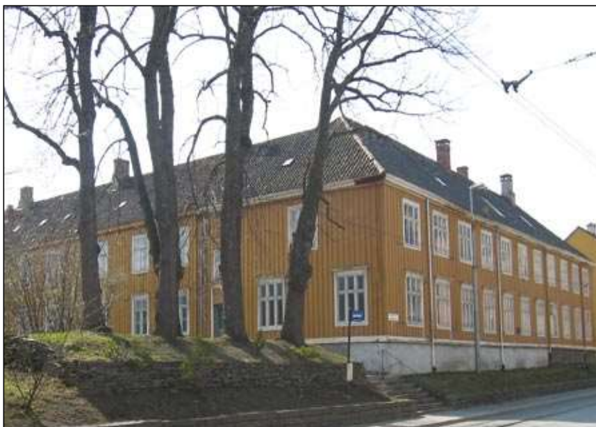
Trondhjems borgerlige Sygehus. Den storslåtte bygningen blei bygd i 1805 med pengestøtte frå Thomas Angells stiftelse. Men på folkemunne blei det frå første stund kalla "Fattigsjukehuset".
