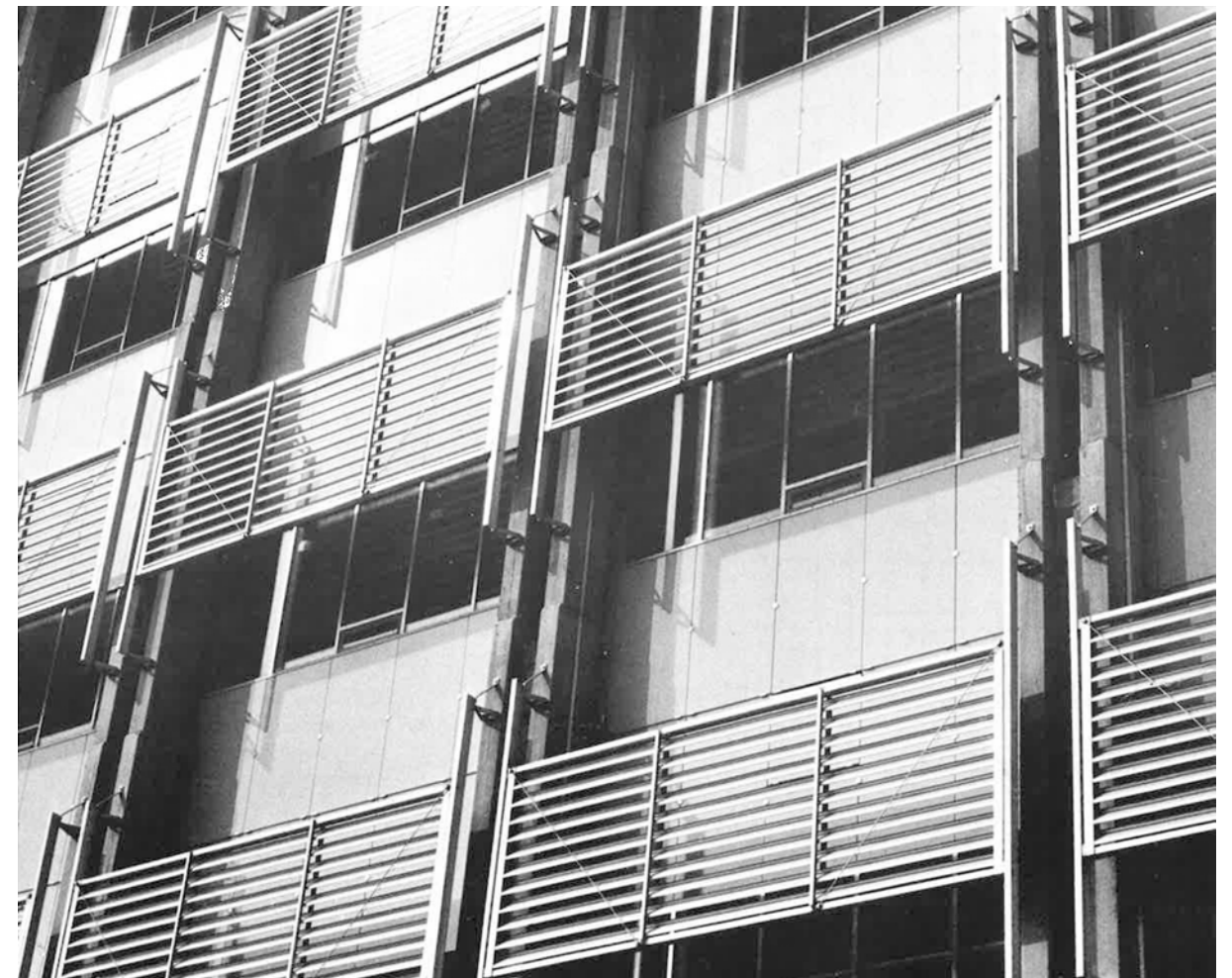
Venstre: Nordre gravlund og Laboratoriebyggets sørøstfasade Over: Arkivfoto av Laboratoriebyggets sørøstfasade, fastmontert solavskjerming
